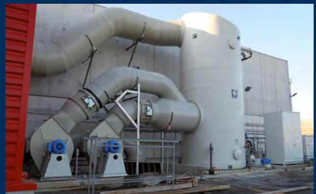
Système d'humidification pour contrôler les odeurs des stations de DMS.
