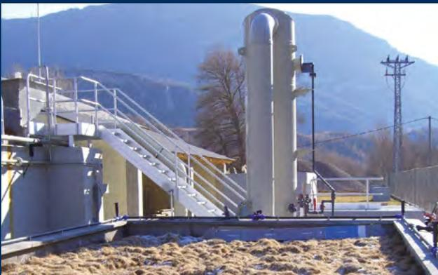
*Contrôle des odeurs par biofiltre dans les Stations Urbaines d'Épuration des Eaux Usées.*
