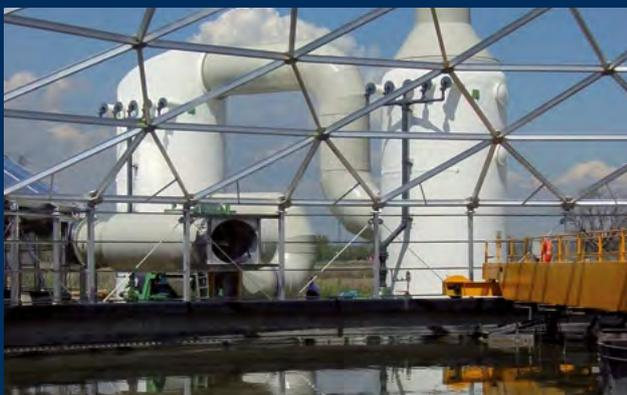
Contrôle des odeurs par voie chimique dans les Stations Urbaines d'Épuration des Eaux Usées.
